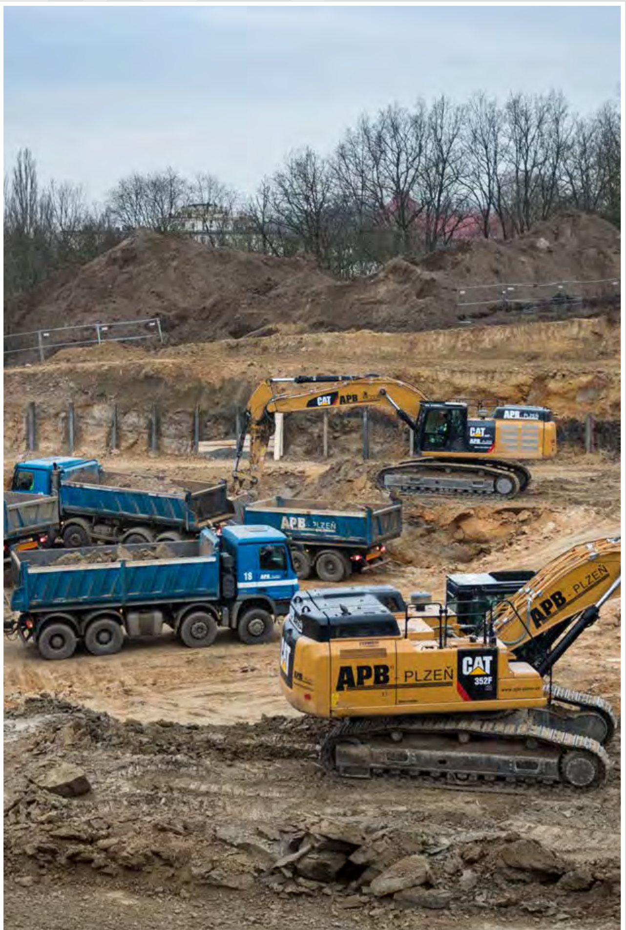
Práce na zakládání univerzitního kampusu UniMeC II.
