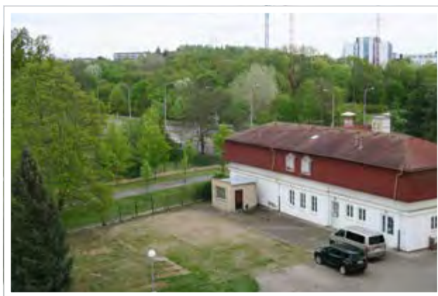
Demolice skladu u starého zvěčnice v areálu Procháskova pavilonu.
