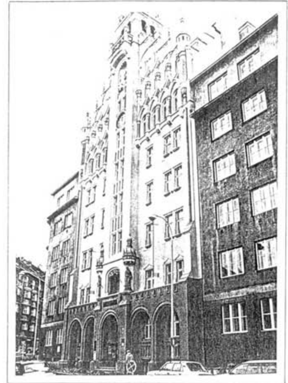
Husitská teologická fakulta UK v Praze 6 - hlavní průčelí
